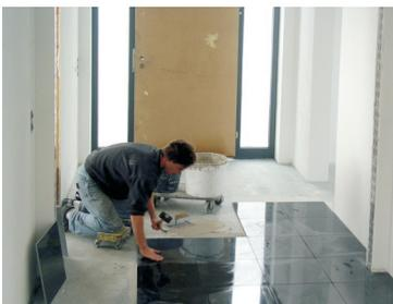
**Mit einem provisorischen Türblatt während der Bauphase lassen sich Feuchteschäden am eigentlichen Haustürblatt vermeiden. Nicht teuer, aber äußerst effektiv.**
